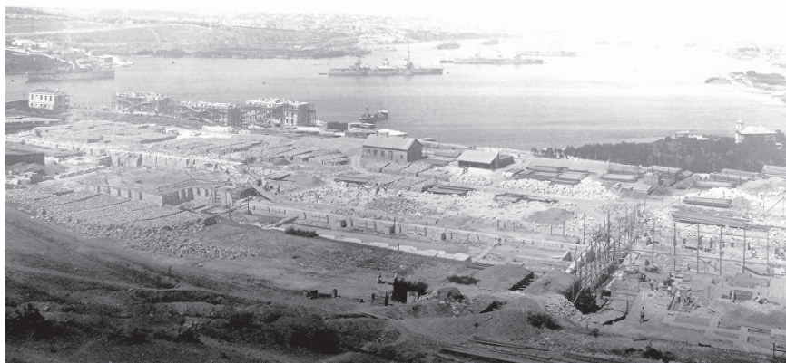
Строительство главного корпуса
